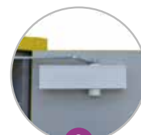
2 Ferme-porte avec thermofusible
