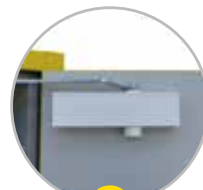
Ferme-porte avec thermofusible
