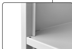
Feuillures verticales des 2 côtés de la porte
